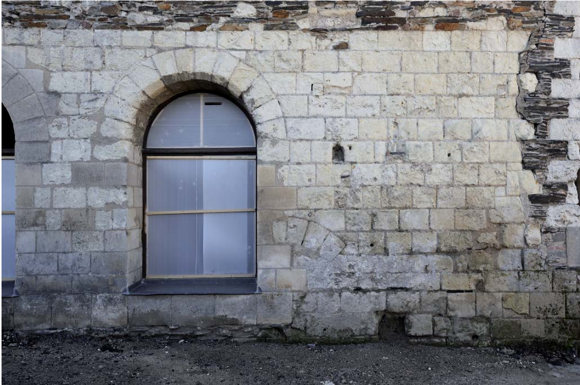
Fig. 35 : Vue de la face ouest du mur 145/148. Cl. Bruno Rousseau, Service inventaire du Patrimoine, Conseil Général de Maine-et-Loire.
