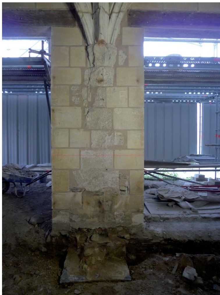
Fig. 51 : Vue du pilier située entre les deux travées occidentales du portique, sur lequel se lisent les traces de bûchage du support engagé, situé à l'aplomb de la retombée des voûtes.
