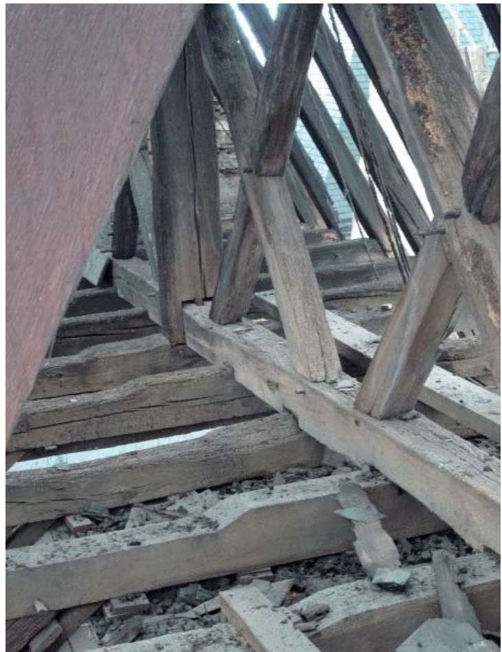
Fig. 75 : Détail des assemblages entre le contreventement et les fermes de la charpente couvrant la partie occidentale du logis royal.
