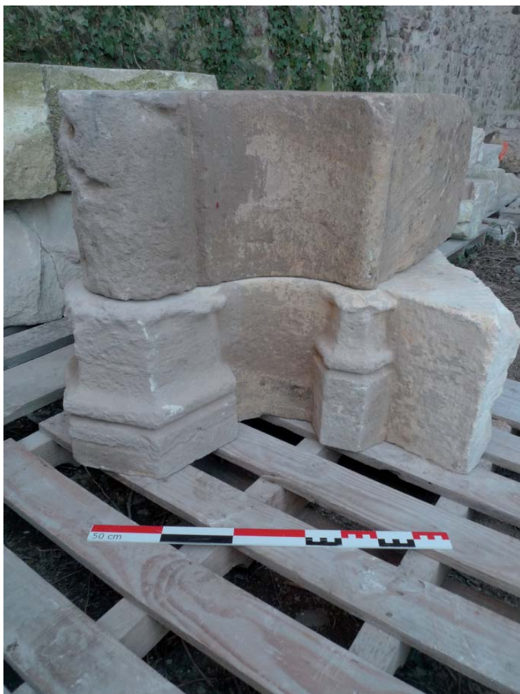
Fig. 86 : Remontage de la partie inférieure du jambage gauche de la cheminée mise en évidence sur le mur de refend de l'aile d'apparat (UA 218 ; isolats 218-6 et 218-7).
