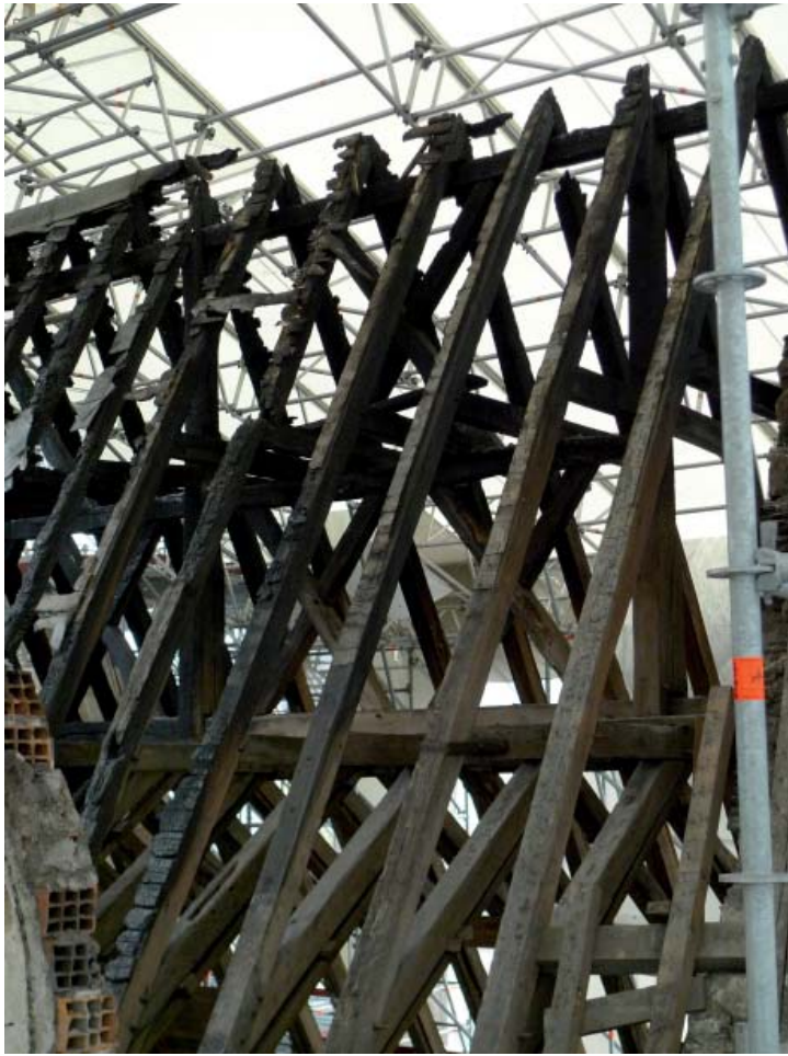
Fig. 74 : Vue de la partie occidentale de la charpente, la moins touchée par l'incendie de janvier 2009.
