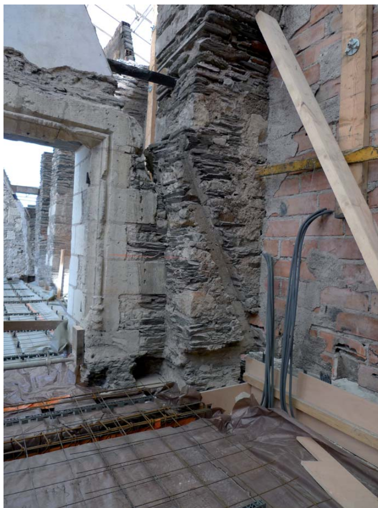
Fig. 77 : Vue du deuxième pilier est portant la charpente de couverture de la galerie. La maçonnerie (UA 117) est venue se plaquer contre le pignon et a moulé le pied d'une des fermes de la charpente couvrant le volume central.
