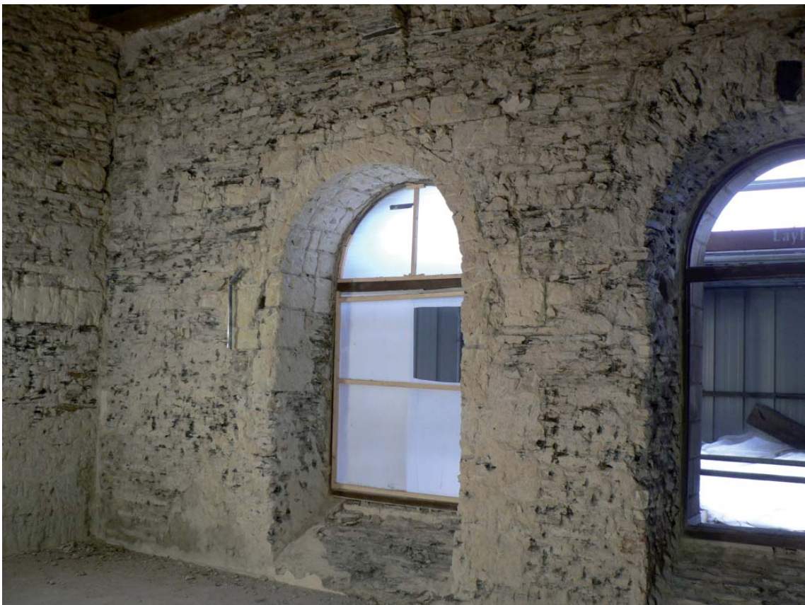
Fig. 36 : Vue de la face est du mur 145/148 après piquetage des enduits.
