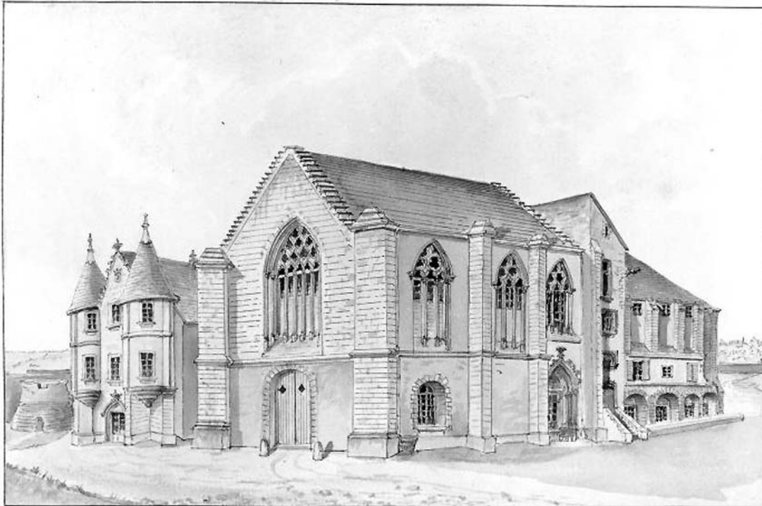
Vue des Façades de la Chapelle et du Petit Château (Côté Sud)
