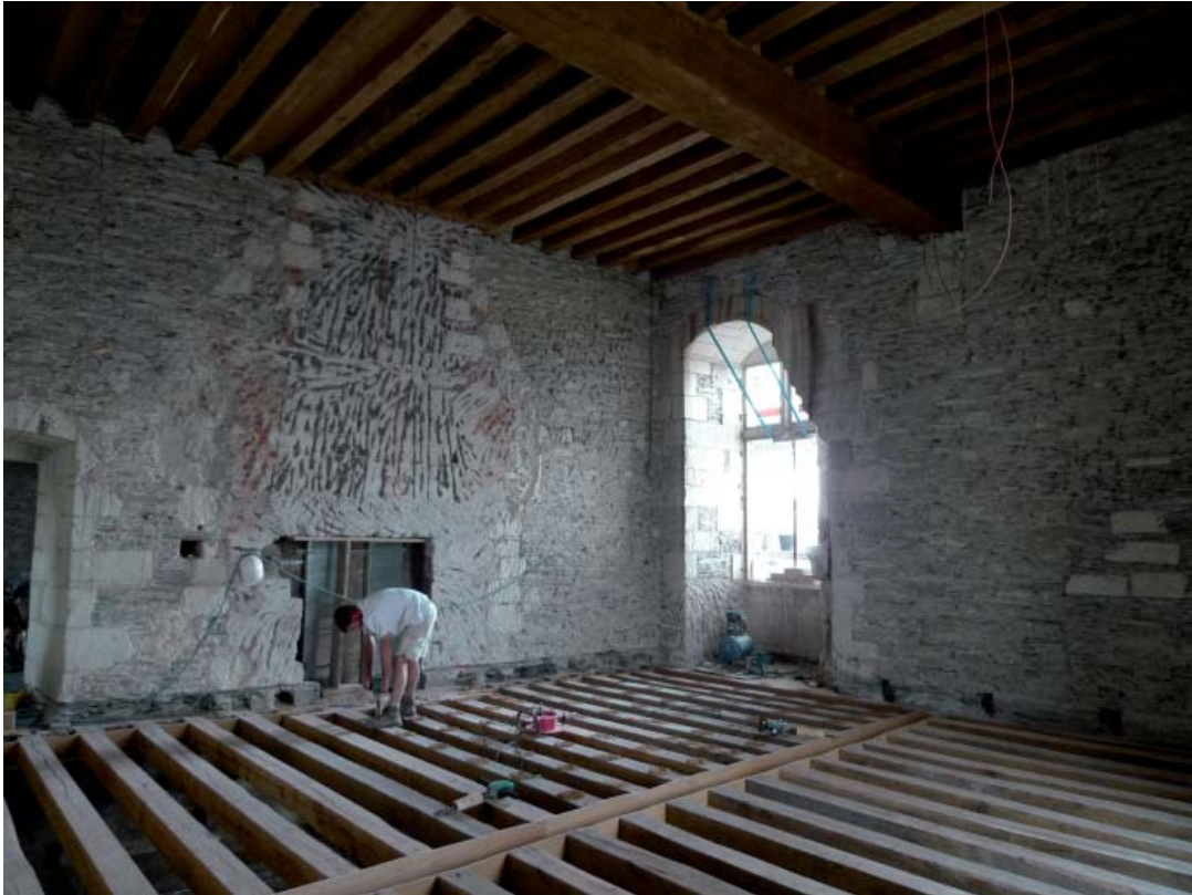
Fig. 43 : Vue de la pièce ouest du premier étage, après piquetage des enduits. Les murs sont montés en plaquettes de schiste ; la pierre de taille de tuffeau n'est employée que pour les encadrements des ouvertures et pour la cheminée.
