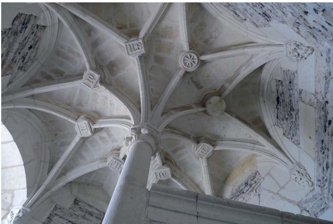
Fig. 57 : Vue de la voûte en palmier couronnant l'escalier en vis nord.
