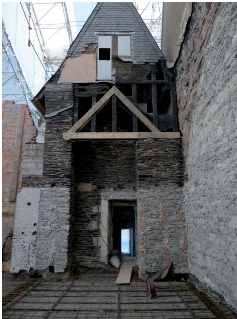
Fig. 45 : Vue du revers de la tour de l'escalier nord après piquetage des enduits et dépose de la charpente. La maçonnerie a été montée autour des pieds de ferme de la charpente couvrant le volume central du logis royal.
