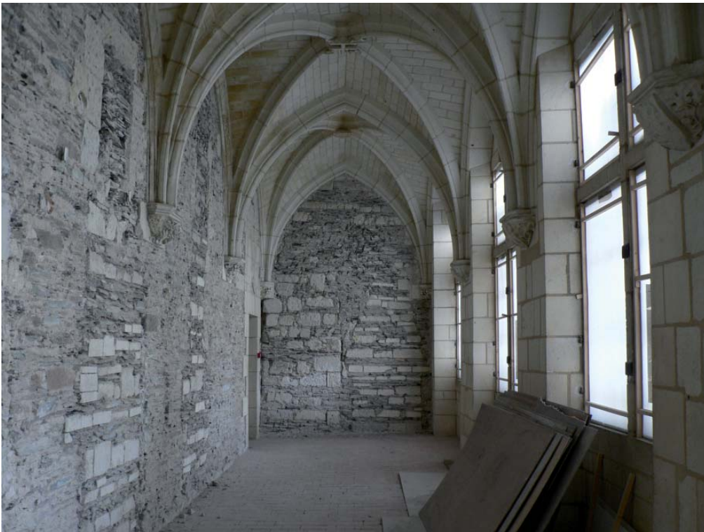
Fig. 55 : Vue vers l'ouest du premier étage de la galerie après piquetage des enduits.
