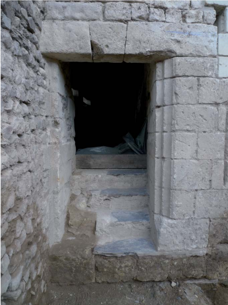
Fig. 54 : Vue de la porte située à la base du pignon ouest (UA 145/148, 147 et 193) ; la différence de traitement de l'emmarquement résulte du déplacement de la porte vers le nord (UA 193).
