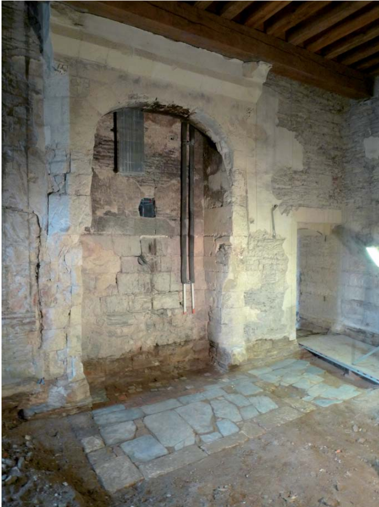
Fig. 62 : Vue de la cheminée de la pièce orientale du rez-de-chaussée du logis royal après son débouchage. Le dallage au sol (US 197) correspond à un aménagement tardif.
